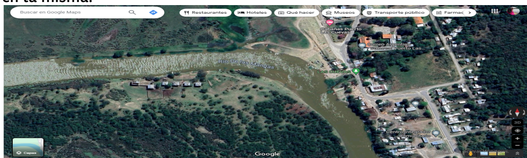
Figura 3: Detalle del área natural protegida Don Miró Gieco, y de los bungalows construidos en la misma.
