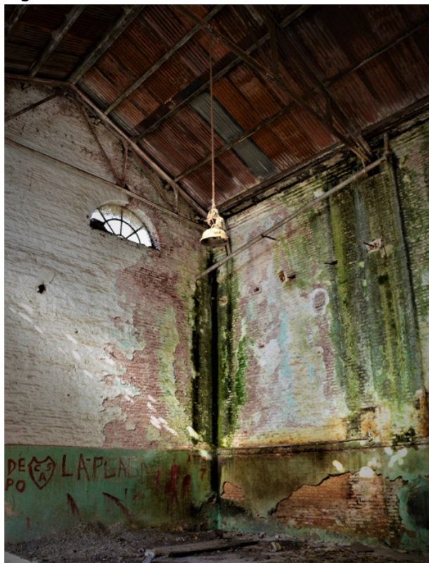
Figura 2 Interior del taller ferroviario
