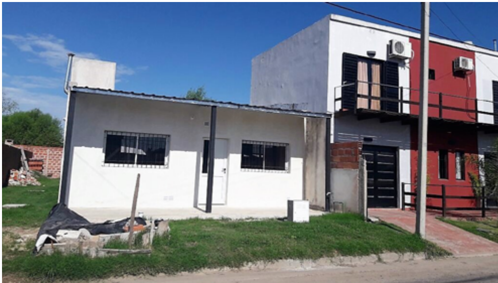
Viviendas Procrear construidas en la localidad de Oro Verde.
