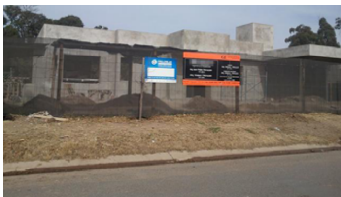
Viviendas particulares en construcción, con cartel Procrear.
