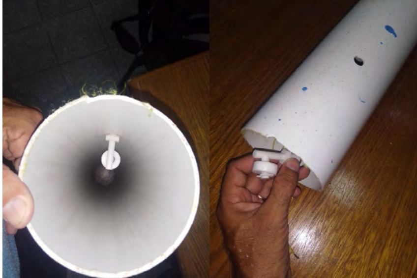
Figura 4. Instalación de sensores de nivel.
